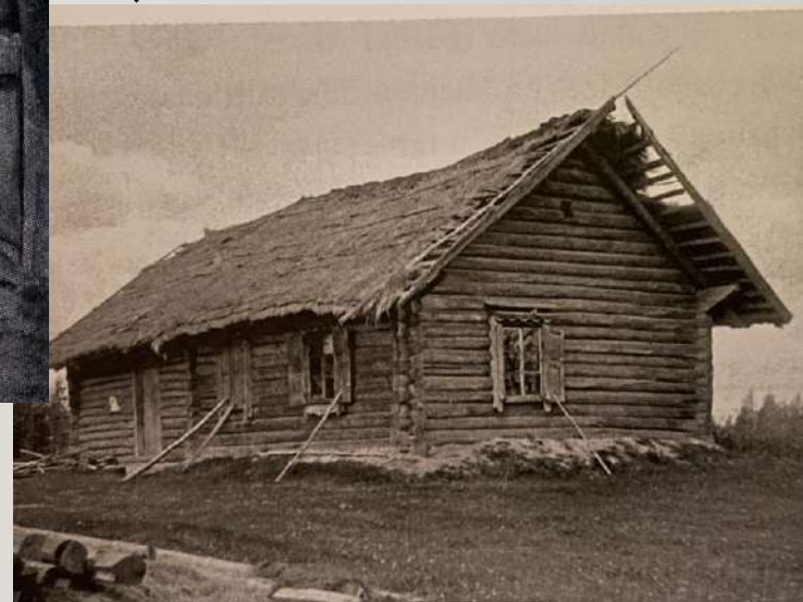
Divdaļīga dzīvojamā māja Silajāņu pagastā Cimermanis, S. Tautas celtniecība Latvijas ainavā . Rīga: Zinātne. 2020
