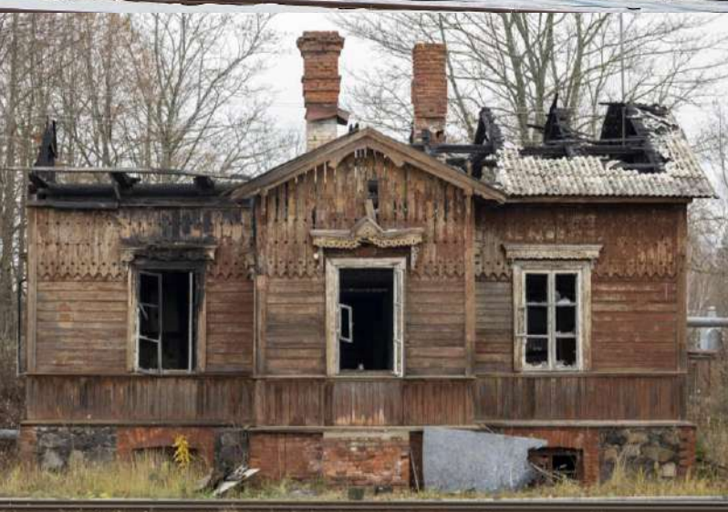
Rēzeknes un Pūpolu stacijas ēkas 2022. gada nogalē Fotogrāfs: Didzis Grodzs
